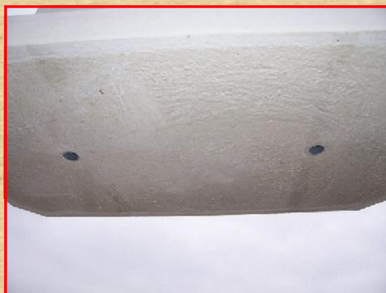
Aan onderzijde voorzien van 2 openingen t.b.v. verankerung.
